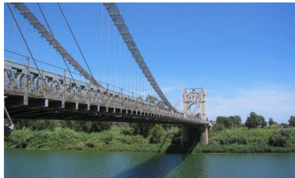
Die berühmte Hängebrücke über den Ebro von Amposta. (Foto: Wikipedia)
