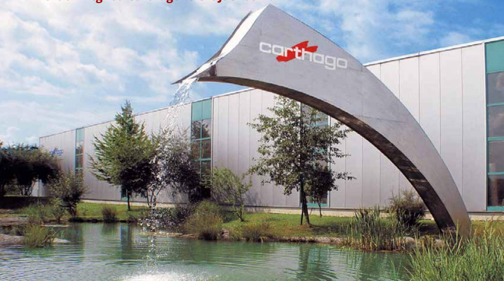
■ Alles im Fluss: Das neue Werksgebäude von Carthago in Aulendorf.
