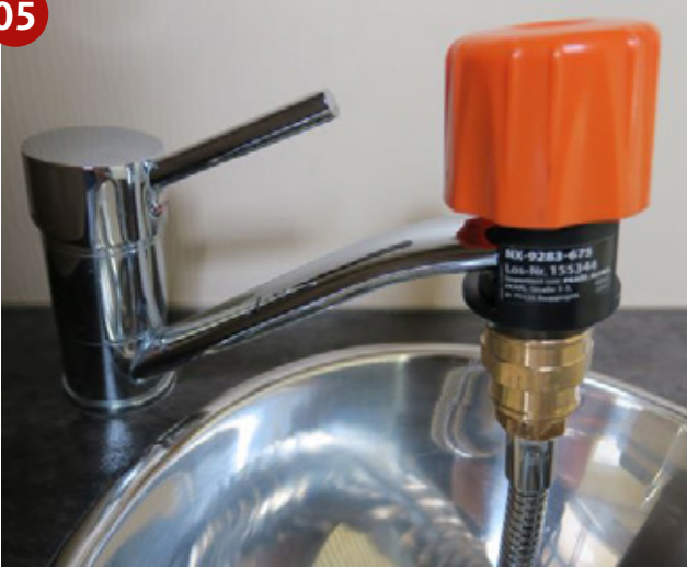
■ Der Gardena-Adapter passt auf den Auslaufhahn im Sanitärraum.
